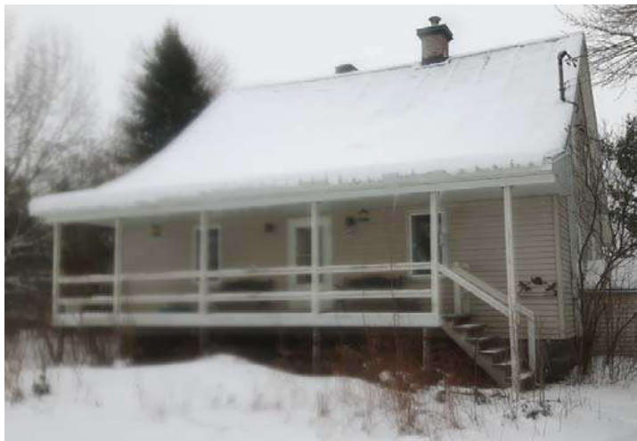
Maison du 4495 des Verdiers
