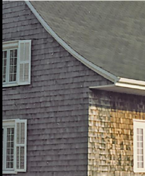
Le larmier vise à chasser l'eau le plus loin possible des murs et des fondations pour éviter l'infiltration d'eau, l'action érosive du gel dans la maison et le pourrissement des murs de bois.
