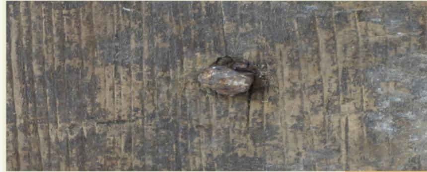
*Clou forgé observé sur le revêtement de planches verticales datant d'avant 1820.*
